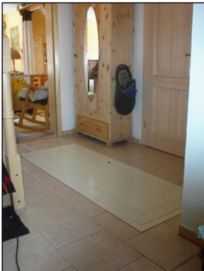
Abb. 6: Radondichte Kellertür
