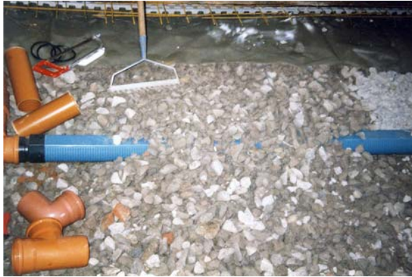
Abb. 3: Drainageröhre in der Schotterschüttung [2]
