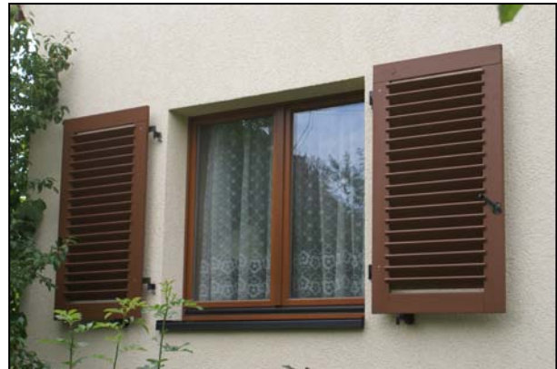
Bild 8 Einbau dichter Fenster im Altbau
