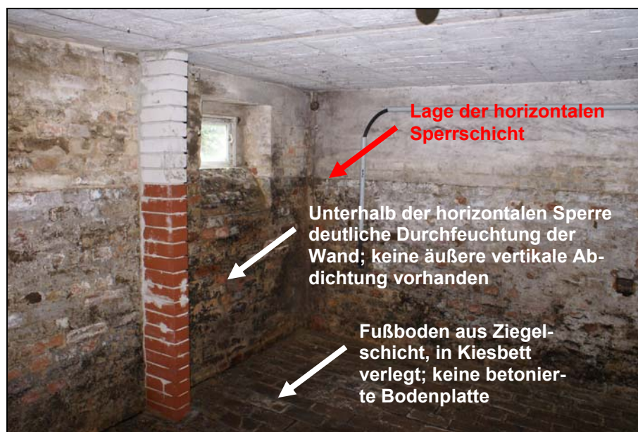
Bild 6: Typischer Keller eines um 1930 errichteten Einfamilienhauses
